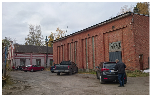
Fra den gamle fabrikk
