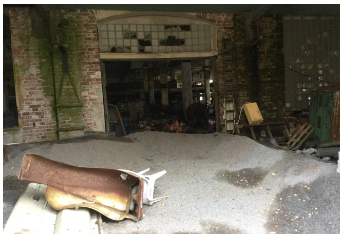
Fra den gamle fabrikk
